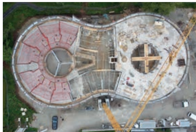
Baustelle Caritashospiz Mutter Teresa
