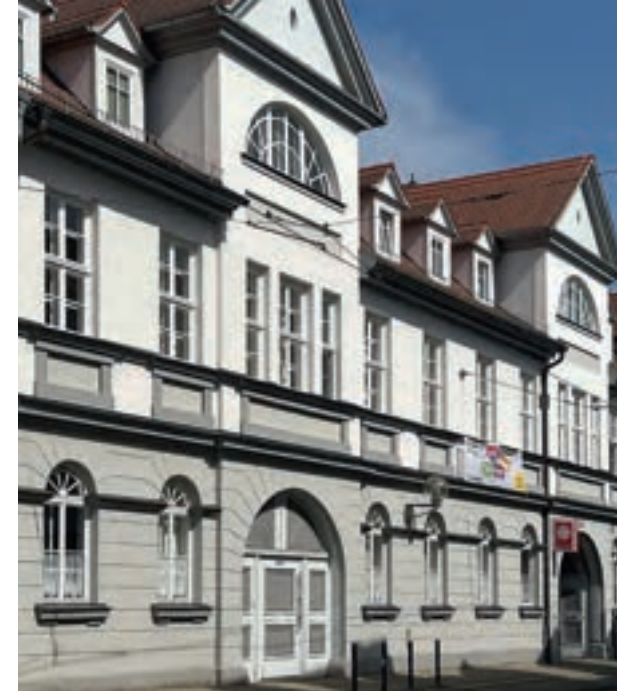
Neue Fassade der Caritas Regionalstelle in Erfurt
