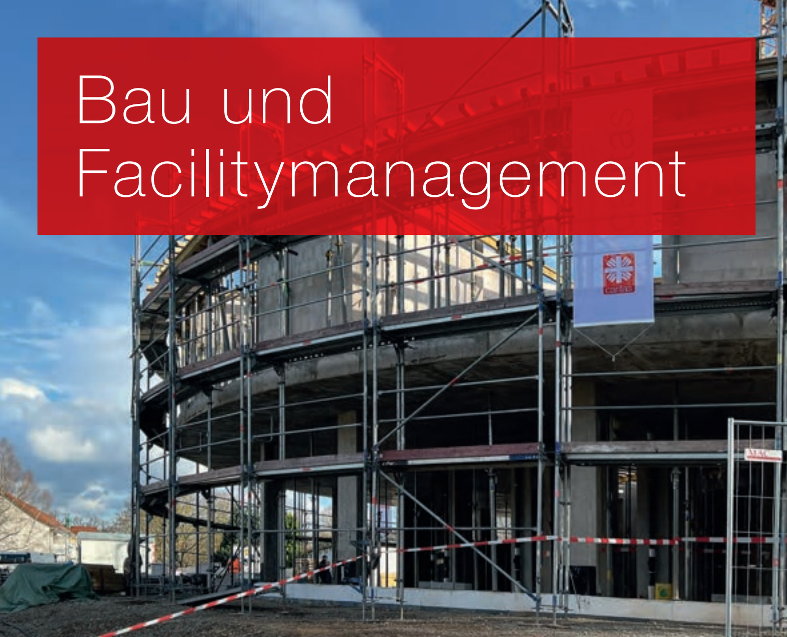
Baustelle Caritashospiz Mutter Teresa
